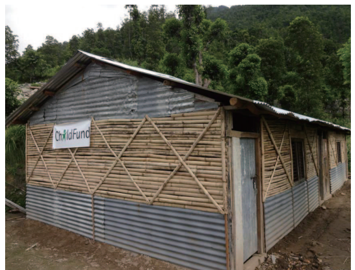
完成した仮設教室
