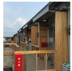
生木が防腐塗装された仮設住宅
