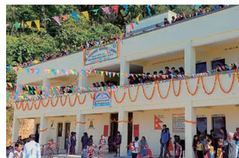
アライアンスからの資金で建設した校舎の竣工式
