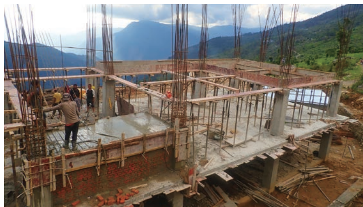
建設中の校舎の様子
