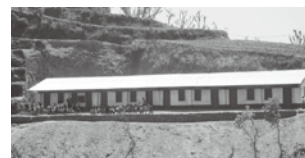
新築された校舎
