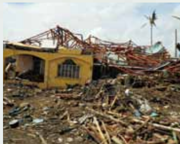
街全体が壊滅的な被害を受け、いたるところにがれきが積まれていた。
