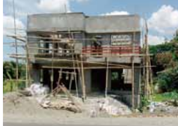
正面から見た組合事務所(4月7日現在)建設風景
