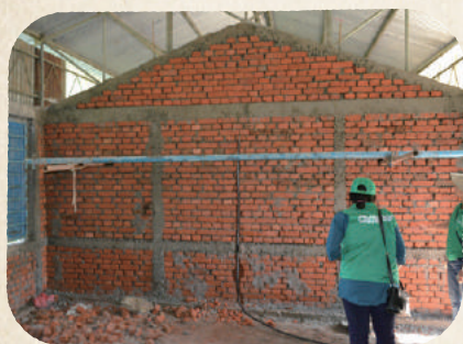
セメントで固める前のレンガの壁面
