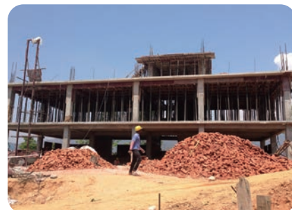
少しずつ建物の形ができあがってきています
