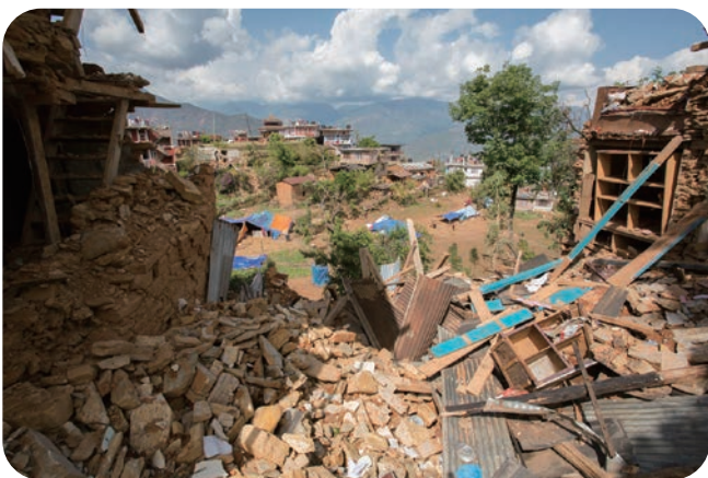
倒壊した家屋の当時の様子
